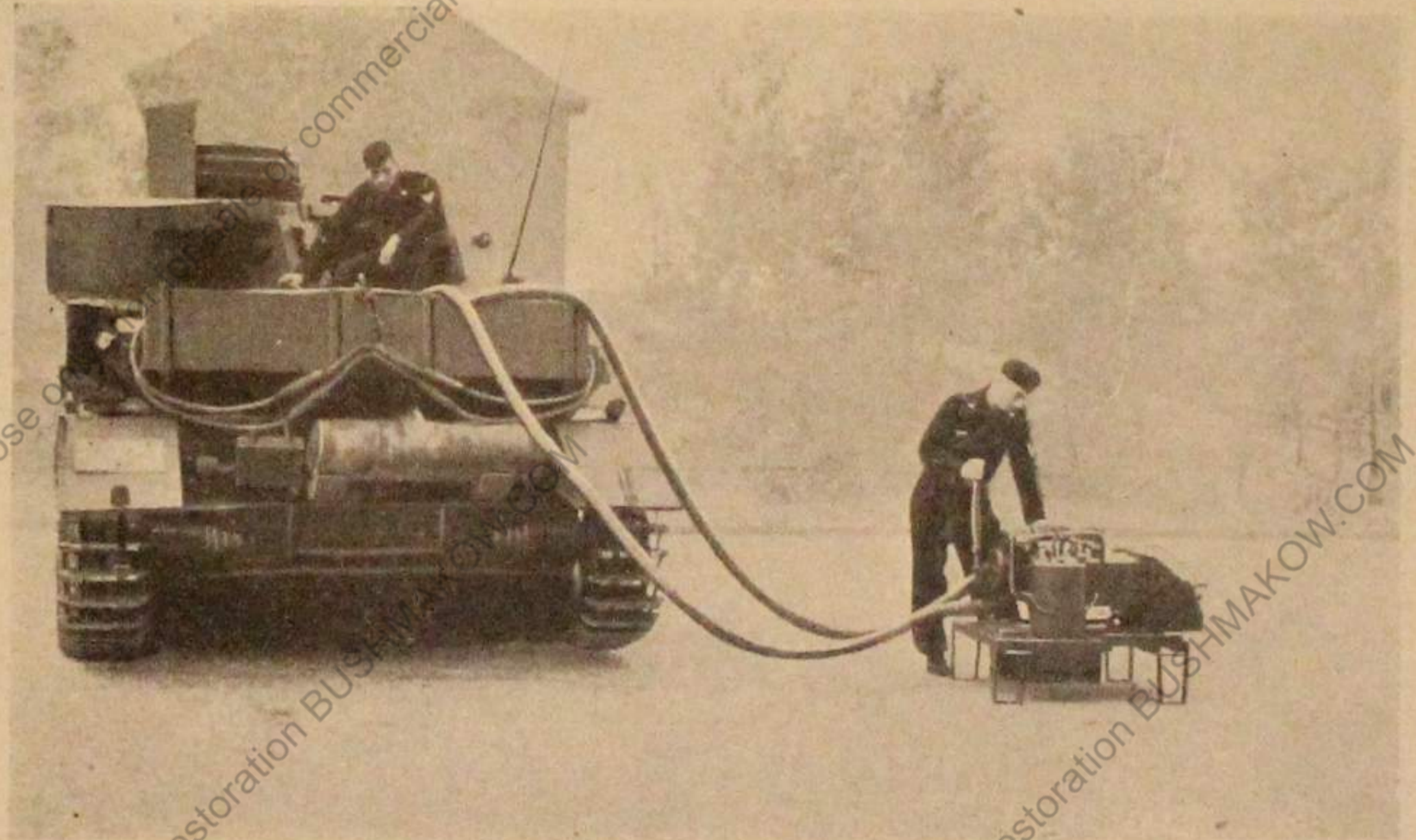
Bild 8. Aufstellen des Kühlwasserheizgerätes
