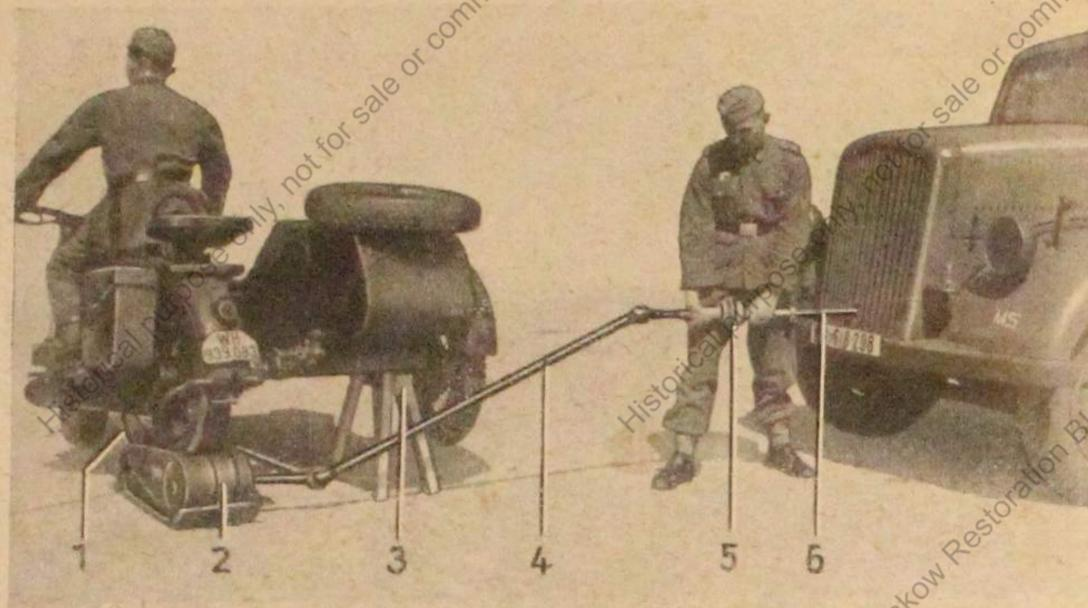
Bild 26 Anlassen des Kfz-Motors durch Krad mit Beiwagen
