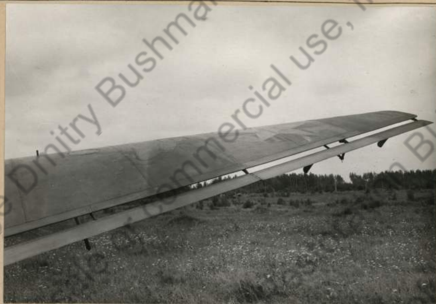
Фото № 23. Закрылки и элероны в нейтральном положении.
