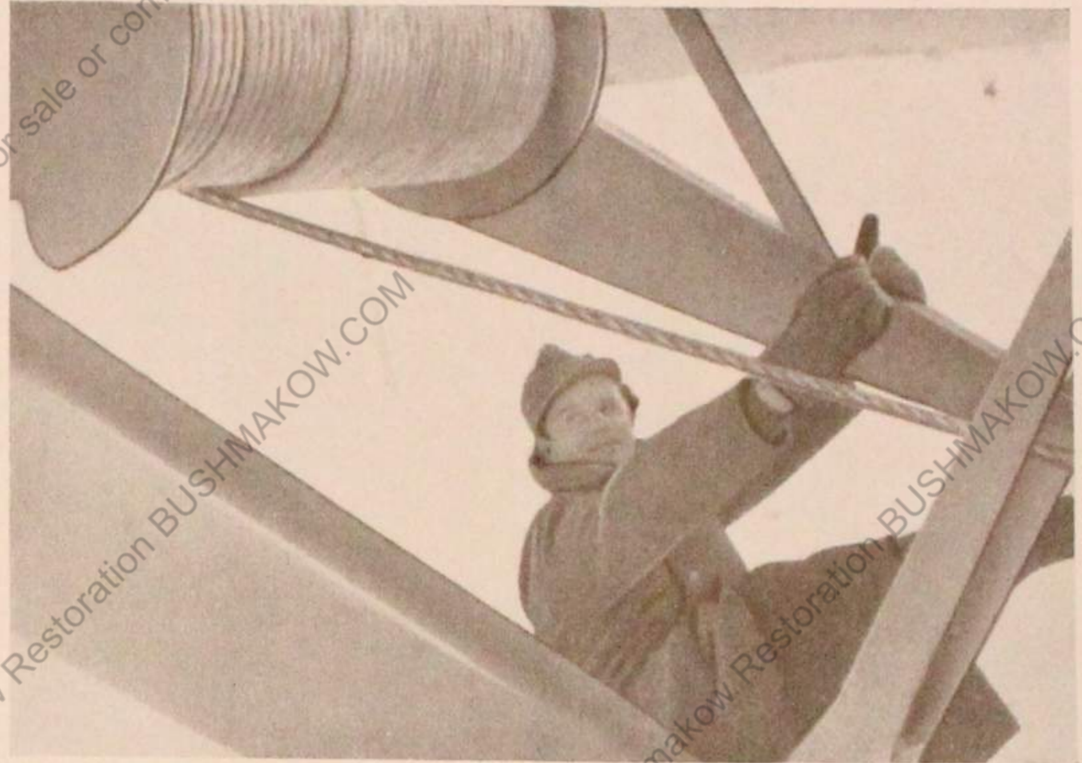
Bild 110 Bremse der Seiltrommel
