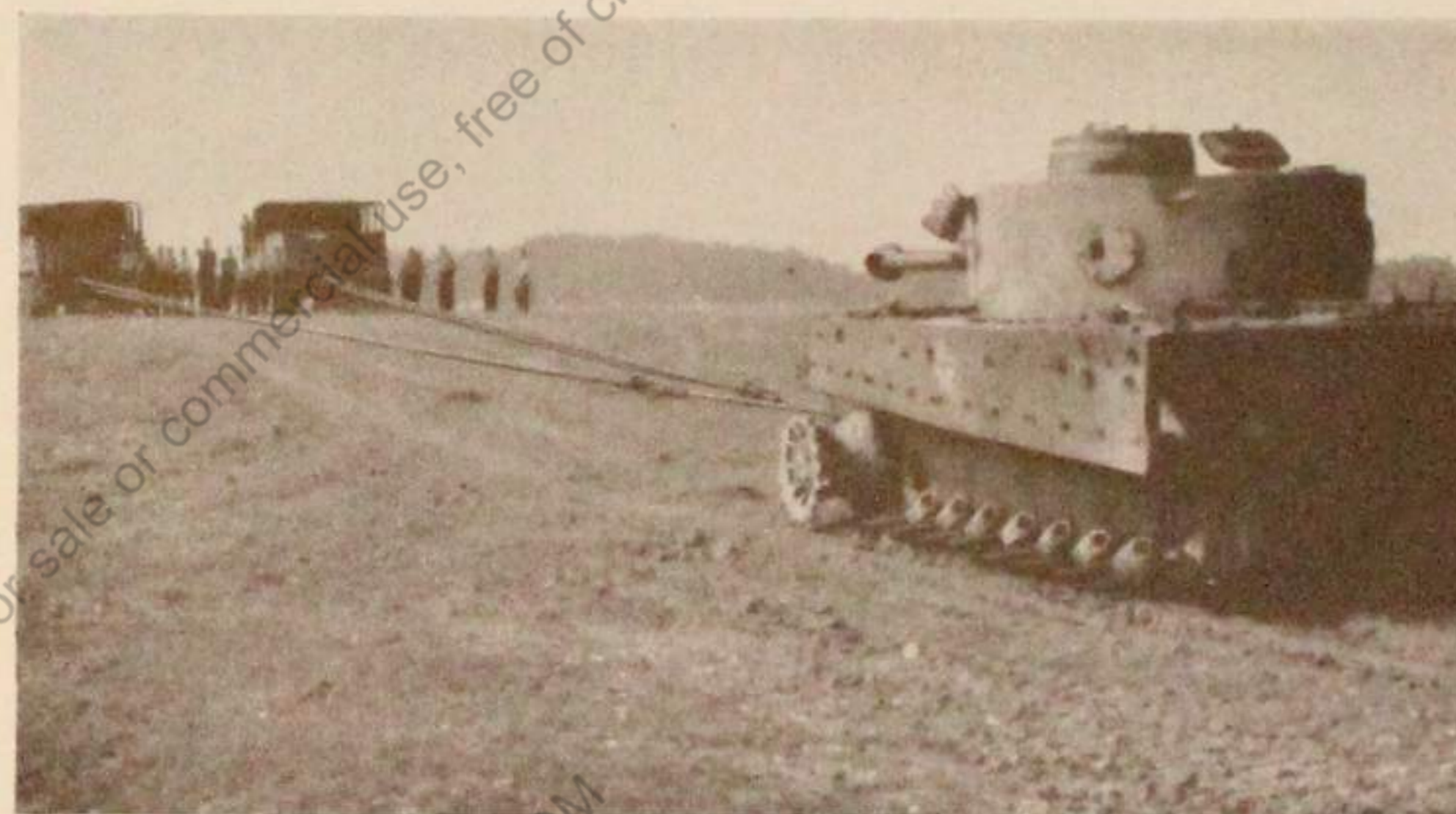
Bild 76 Abschleppen eines nicht rollfähigen Pz Kpfw auf Abschleppbalken
