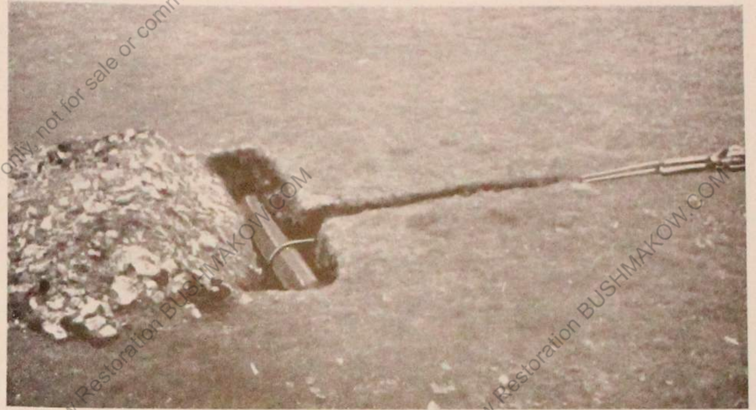
Bild 35 Verankerung durch eine in den Boden versenkte Bahnschwelle
