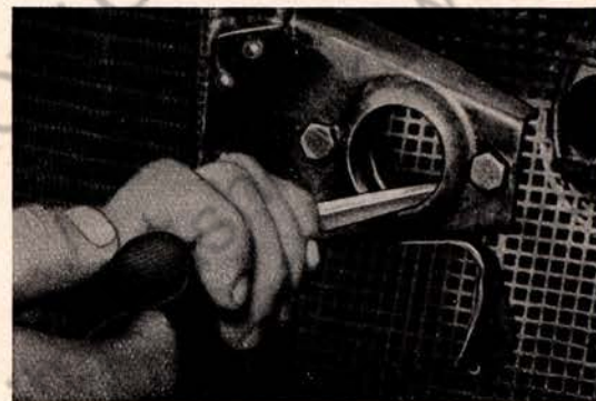
Bild 22. Nacharbeiten des Trägers am Kühler
