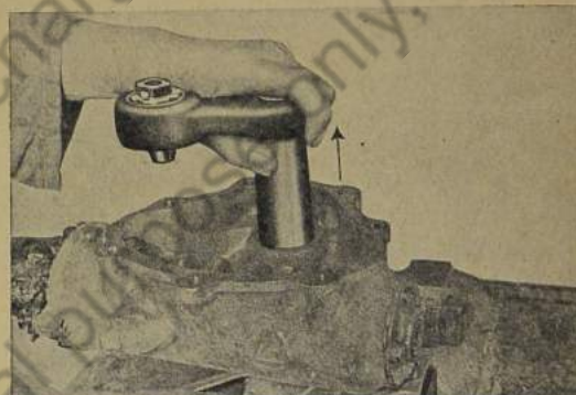
Bild 569: Lenkrollenwelle herausheben
