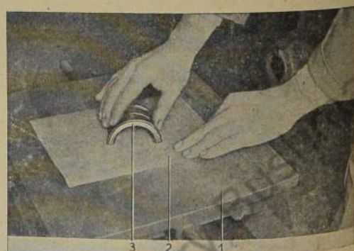
Bild 93: Stoßflächen der Lagerschale abziehen
