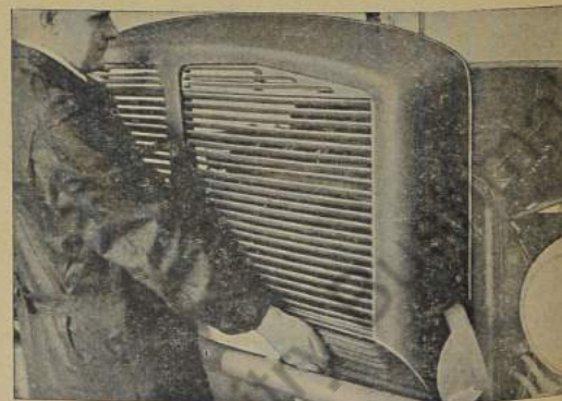
Bild 217: Kühlerverkleidung mit -abdeckung (Jalousie) abheben
