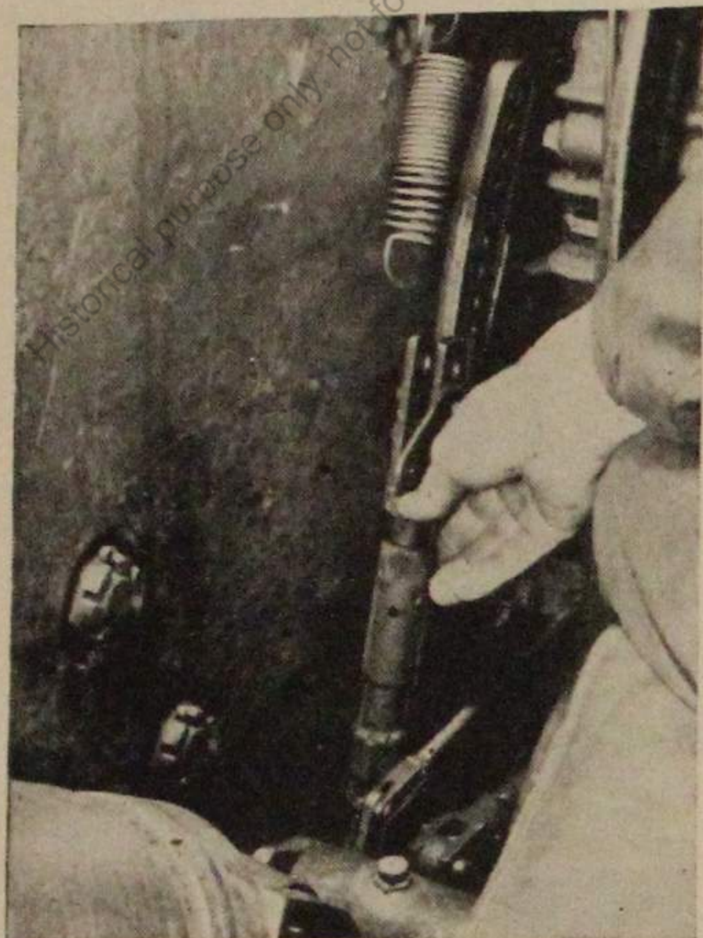
Spannschloß mit Gabel vom Bremshebel abziehen.
