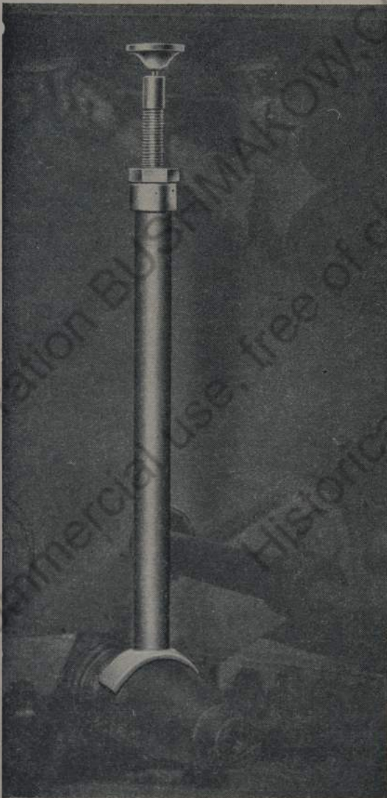
Winde für Stabfedereinbau
